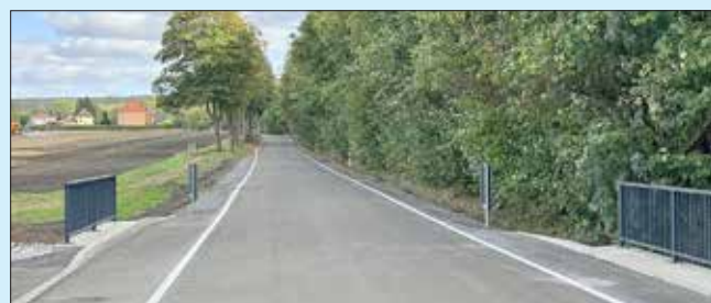
Fertiges Brückenbauwerk an der K7928 bei Mölbis
